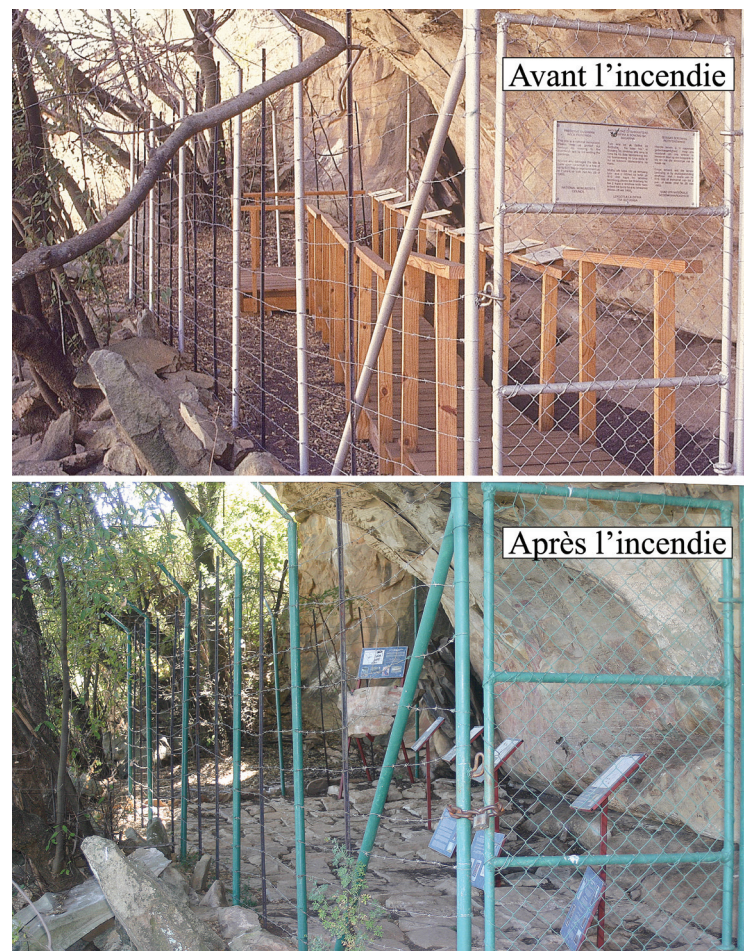
Fig. 1. Un exemple de promenade en bois dans un site d'art rupestre de l'État libre d'Orange. La promenade et les panneaux en bois ont brûlé lors d'un feu de brousse, causant des dégâts considérables aux peintures rupestres. Le site a été restauré avec des matériaux entièrement ininflammables, par exemple des sols en pierre et des panneaux de signalisation en métal. (Photo du haut © G. Blundell ; photo du bas © B. Smith.)
