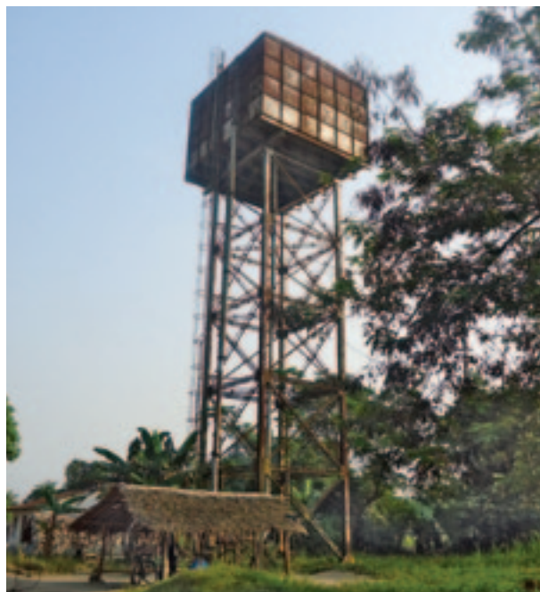
Château d'eau en panne à Aketi.
