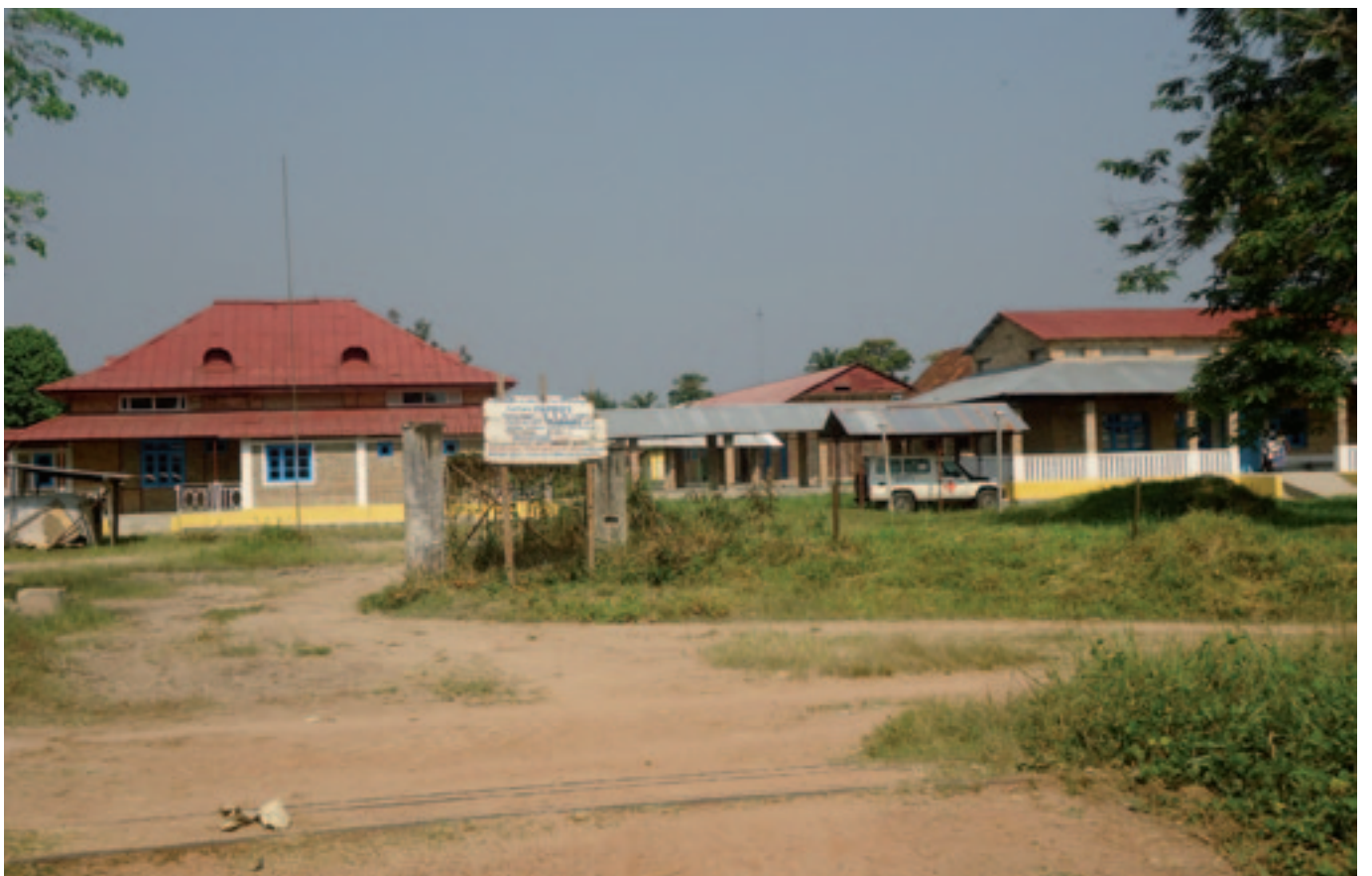
Hôpital général de référence Aketi en réhabilitation. (Photo équipe locale, 2012.)
