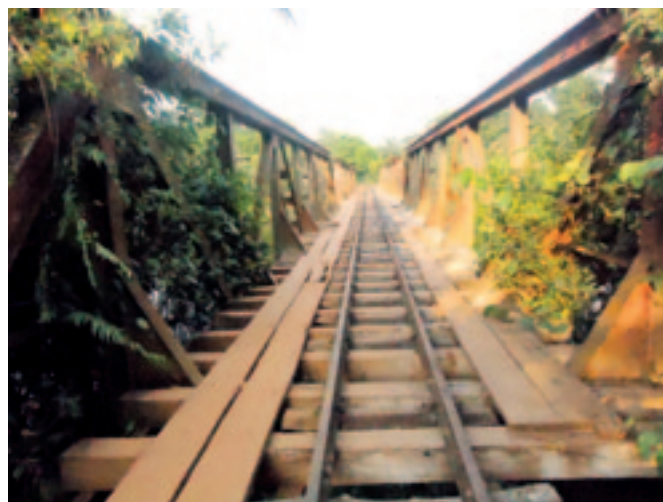
Pont mixte route-rail à Guma (Pk 85). (Photo équipe locale, 2012.)
