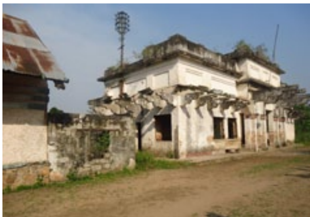
Entrepôt détruit au port Chaltin (Aketi).
