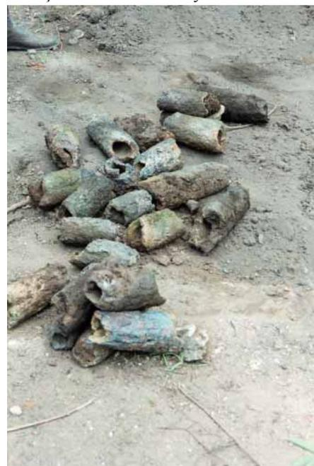
Les tronçons d'anciennes tuyères sont utilisés pour réserver l'espace nécessaire pour l'orifice inférieur du fourneau.
