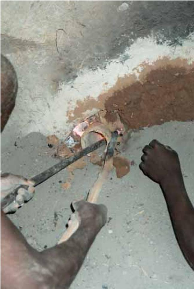
Extraction d'une tuyère endommagée.
