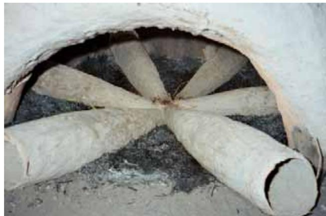
Détail de l'intérieur du fourneau: disposition des tuyères.
